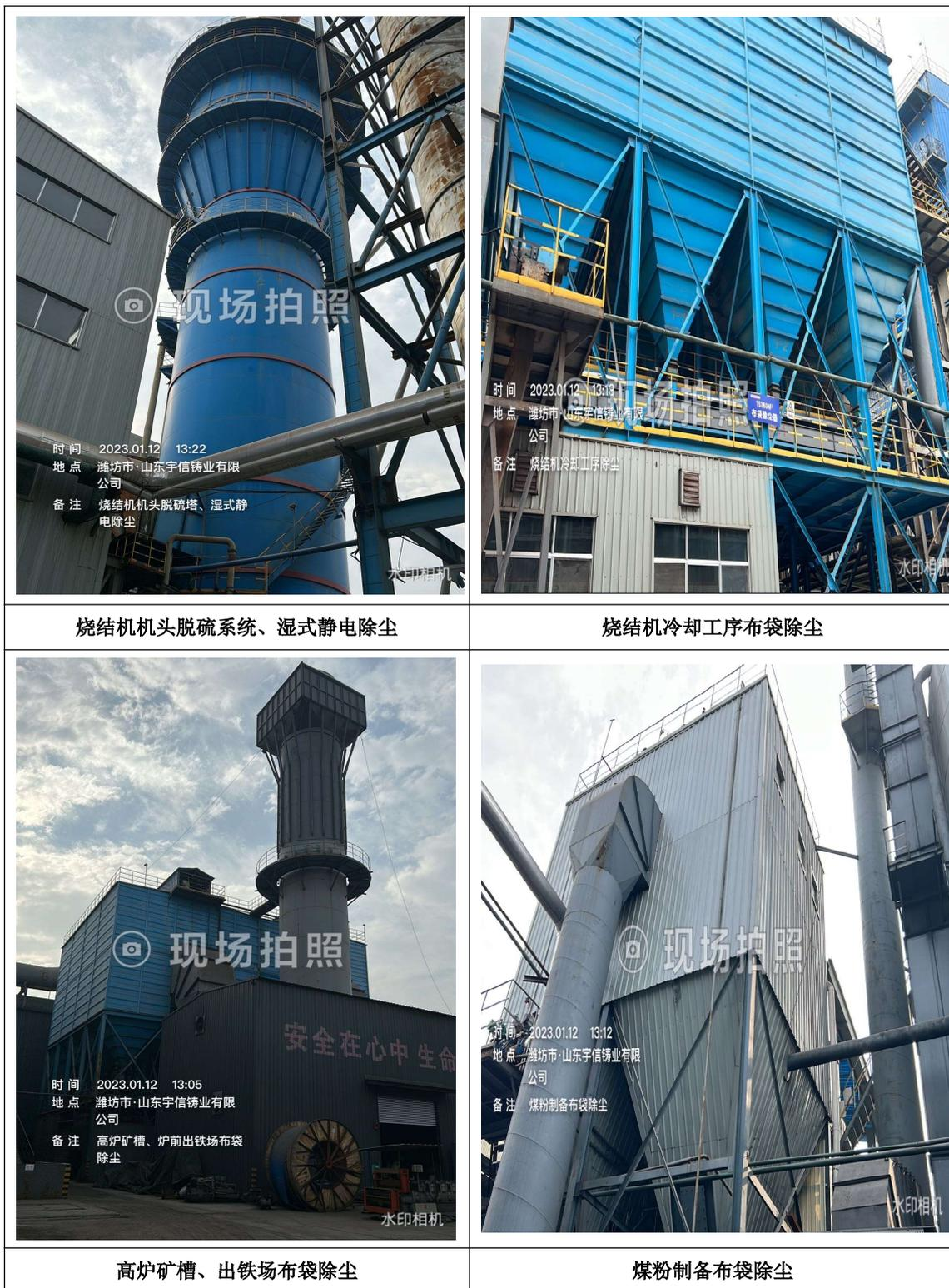
图 4.2-2 排气筒及环保处理设施照片
