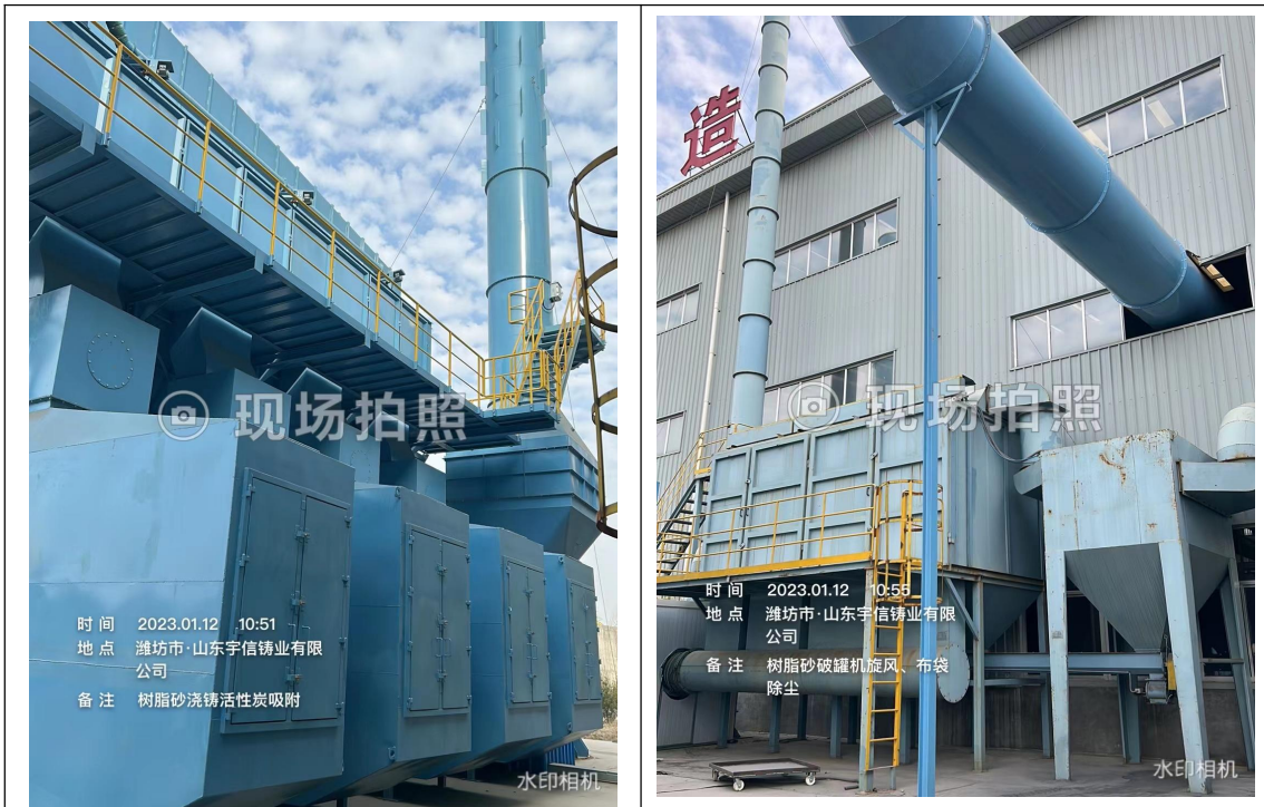
树脂砂挥发性有机物排气筒
