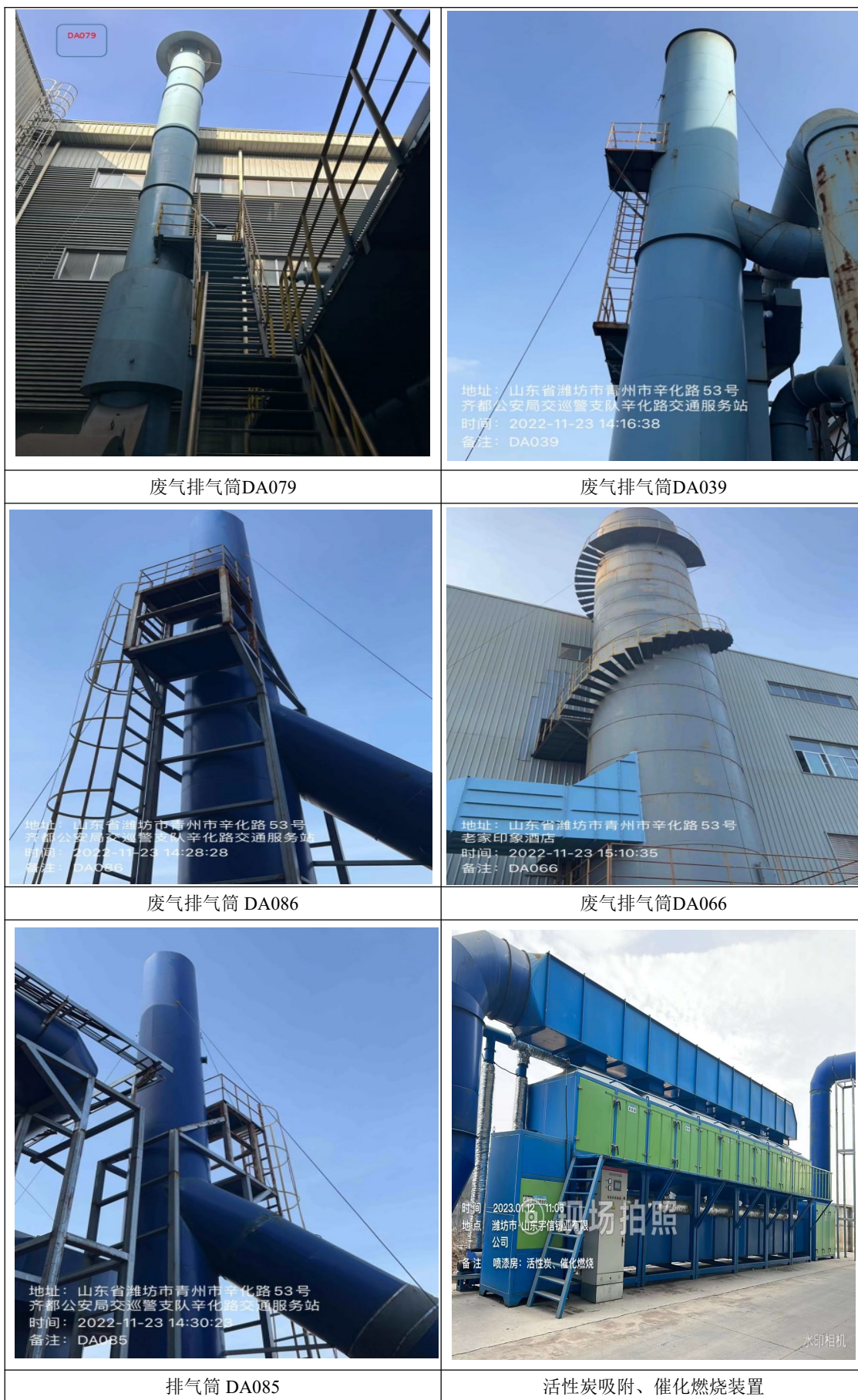
图 4.2-2 排气筒及环保处理装置照片
