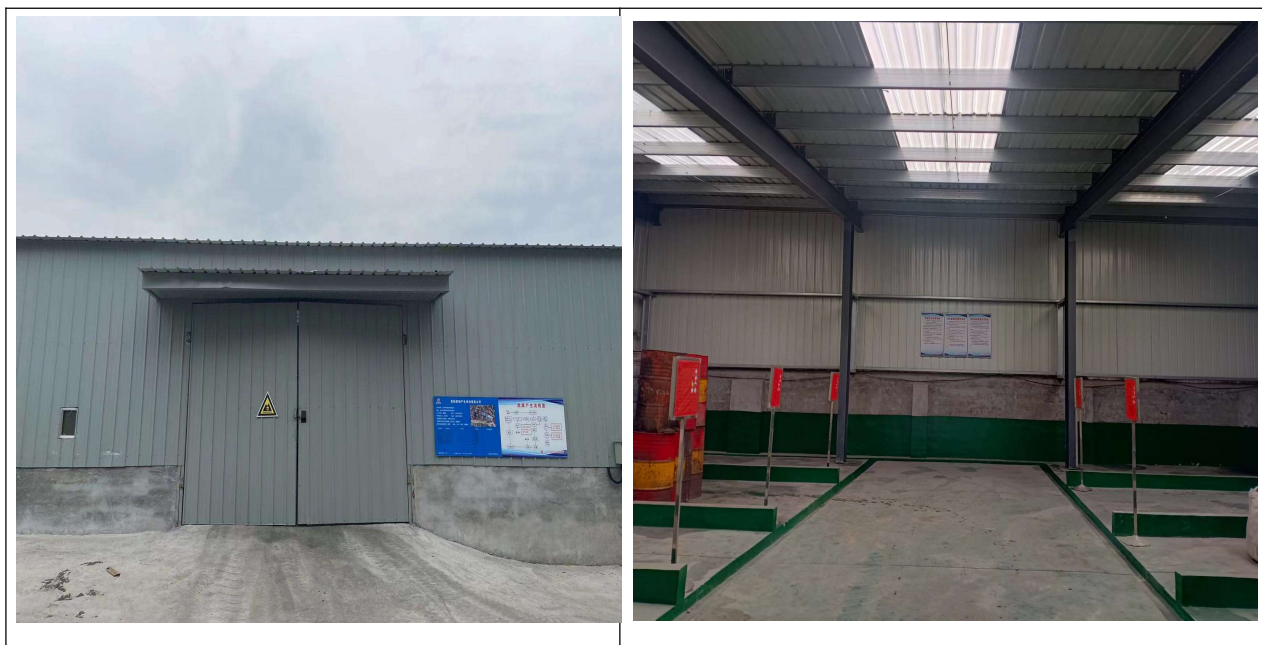
图 4.1-2 危险废物暂存间
