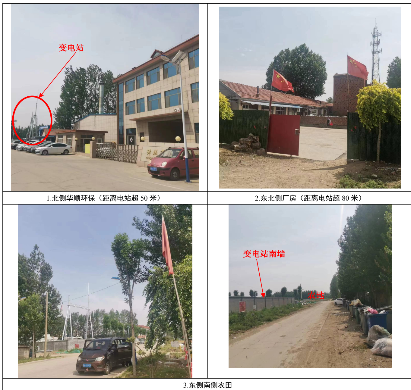
图 4-1 本工程变电站周围现场照片
