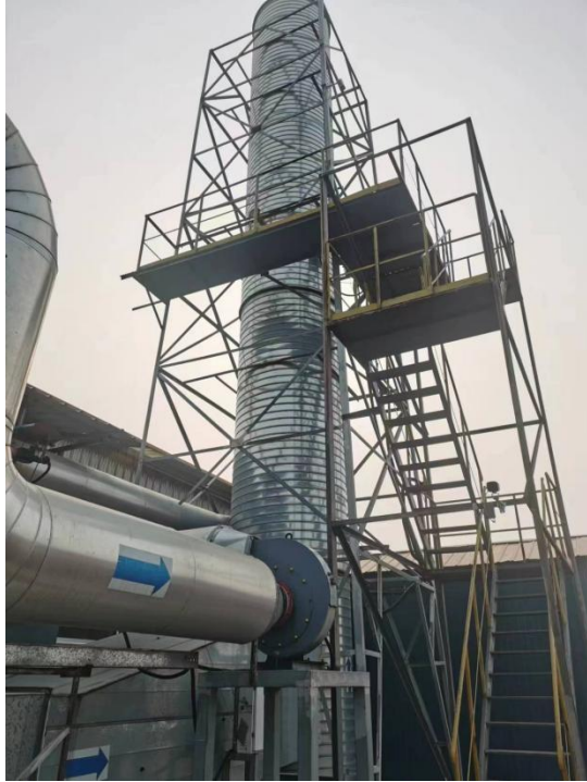
密炼车间废气排气筒 P1
