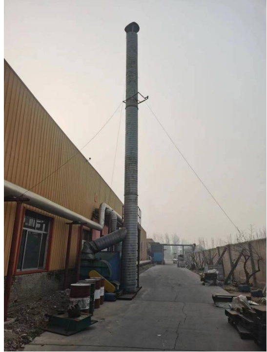
复合挤出车间废气排气筒 P3
