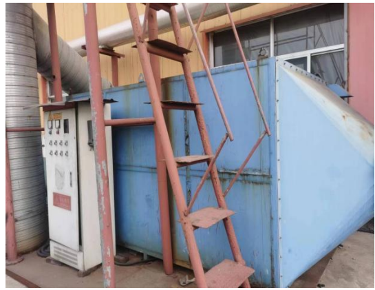
复合挤出车间废气处理设施
